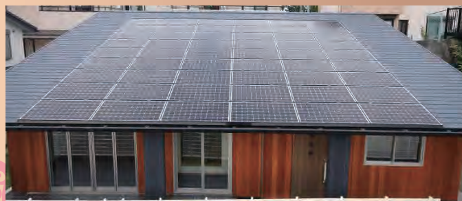
❖ 10KWの太陽光・屋根一体型パネル搭載（三重県初施工）
